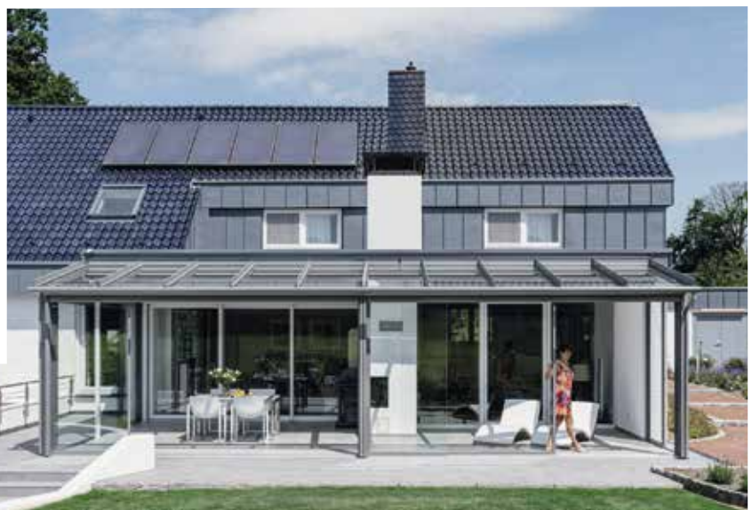
Kaltwintergarten mit Terrassenüberdachung
